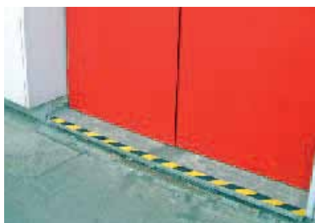
Escalones en salidas de emergencia
